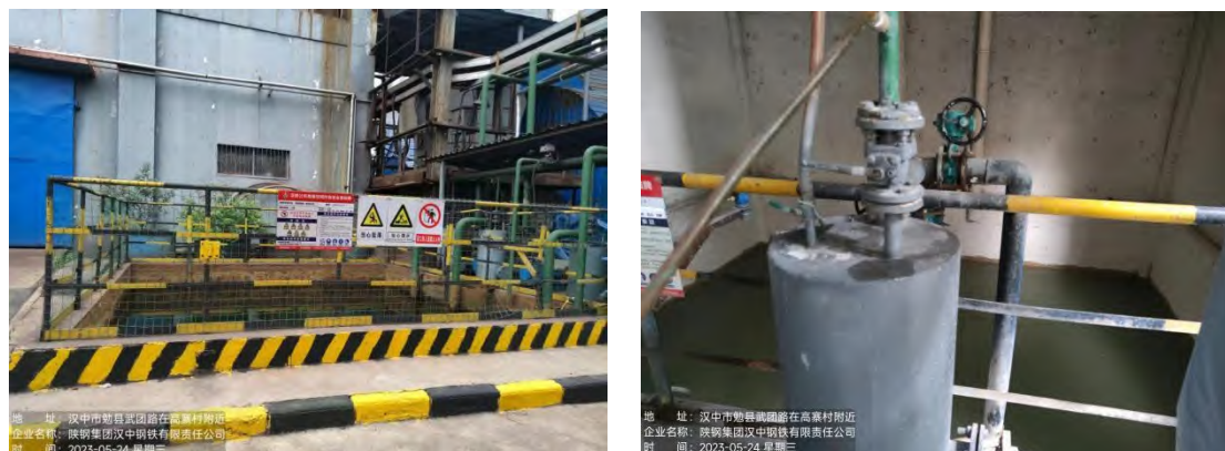
球团工序地下水池体，深度 3.0m
