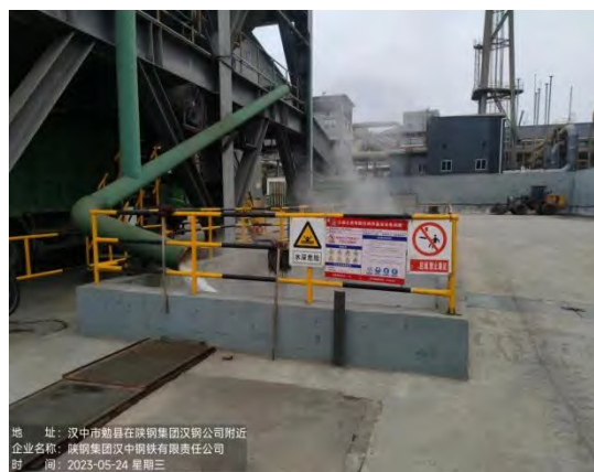
炼铁工序地下水池体，深度 6.0m
